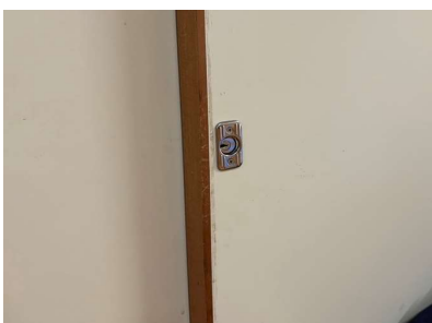
調理室扉（廊下側）
