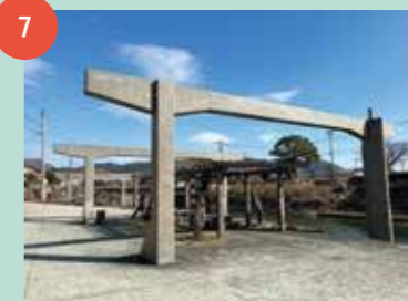
6 潮干狩りのときの海のように底が見える川。7 かつてのクレーン台。船で運ばれてきた陶石などをクレーンで移し変えたという。8 棚路と呼ばれる、川へ降りる階段。
