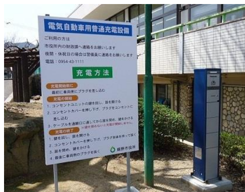
嬉野庁舎前駐車場
