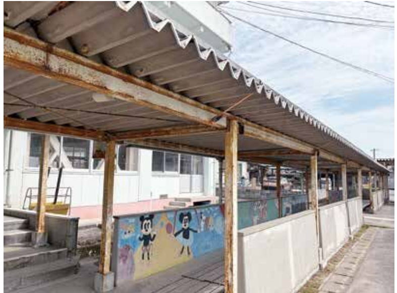
▲ 改修予定の渡り廊下
