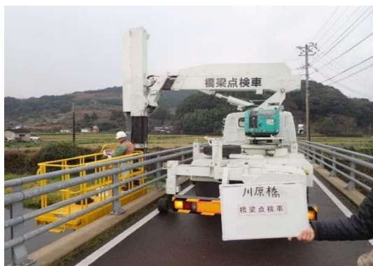
橋梁点検車による定期点検
