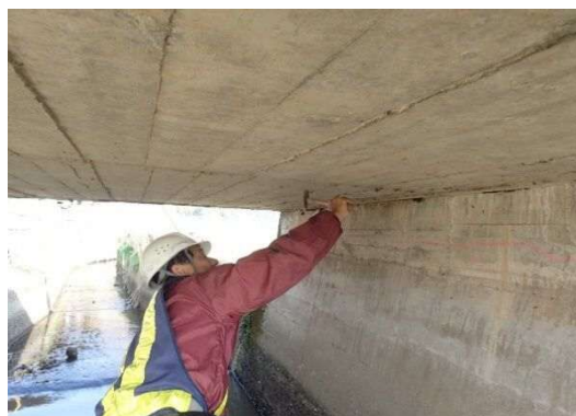
定期点検(打音検査)状況
