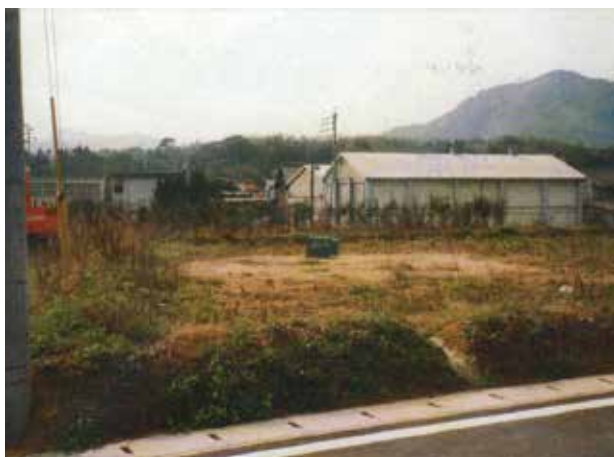
整地前の現場
