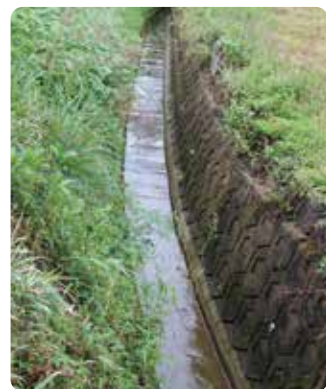
導水路(権現山付近)
