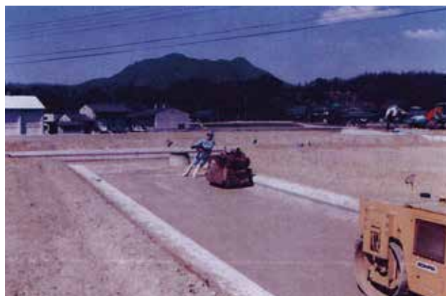
区画整地工事
