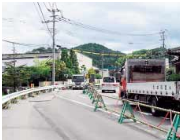
完成まぢかの県道改良工事
