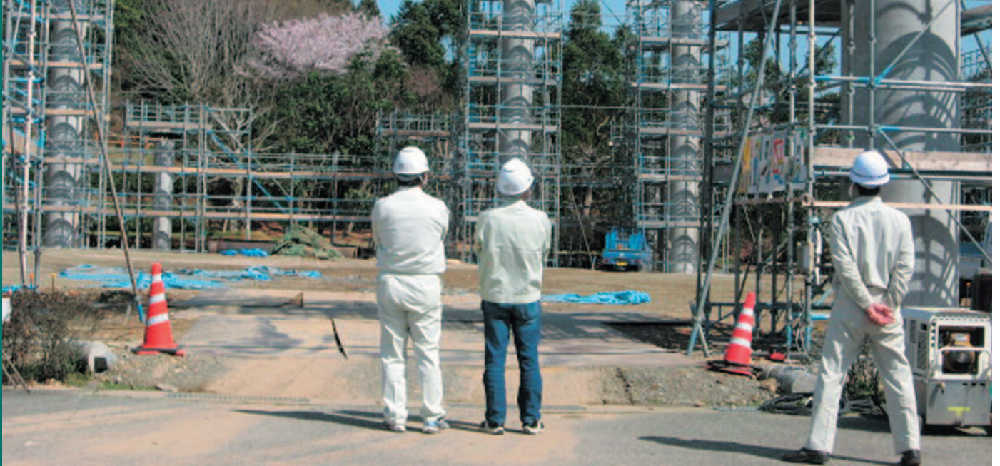
▲着々と工事が進む屋内運動場
