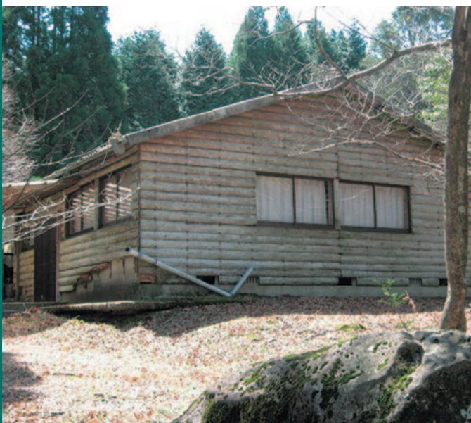
▲改修されるバンガロー
