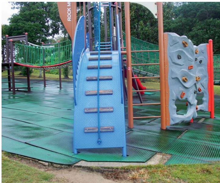
コンクリートがむき出しになったみゆき公園遊具場
