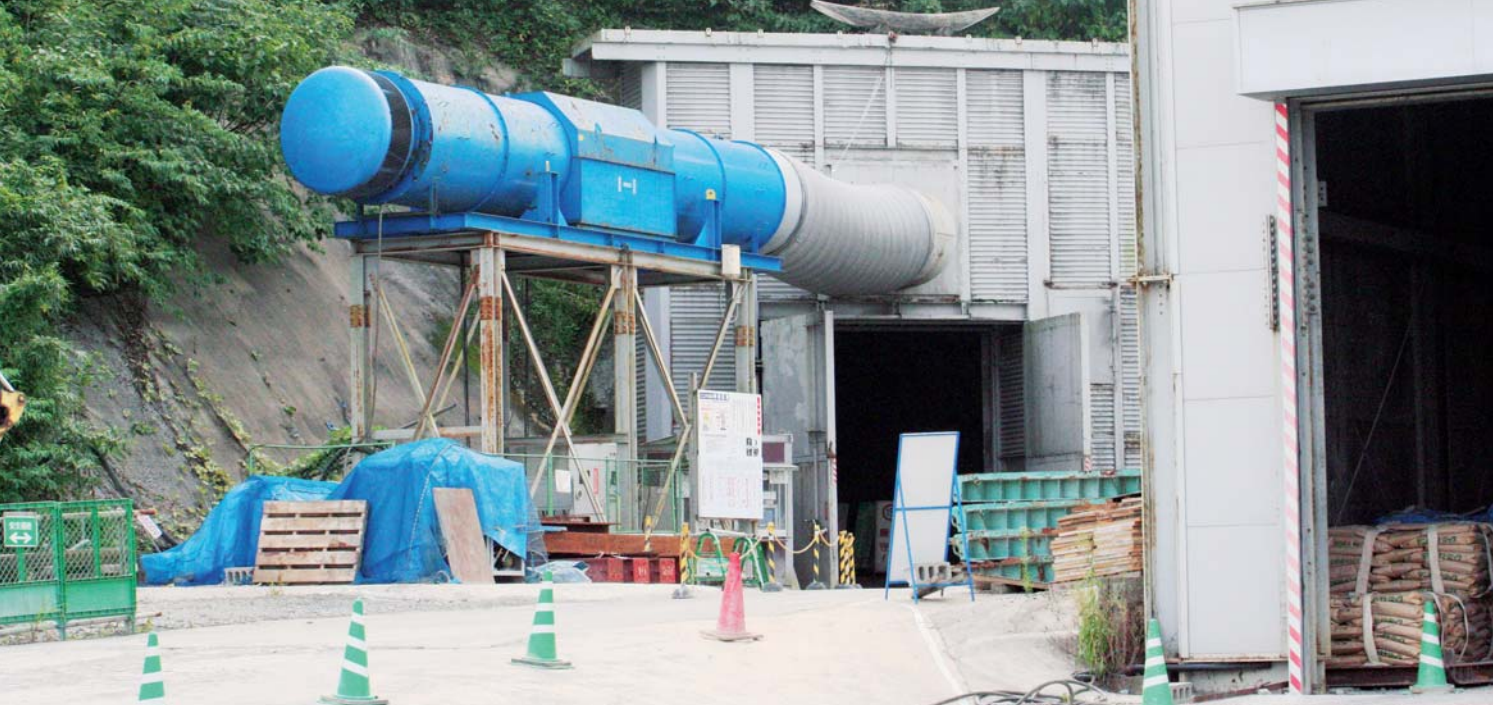
着々と工事が進む新幹線トンネル工事
