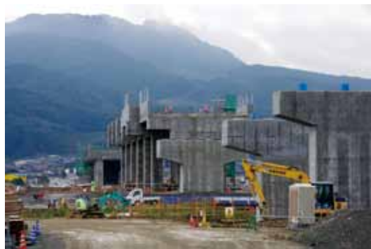
▲進む新幹線工事
