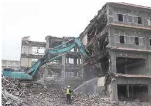
▲ 旧医療センター解体に利用されている源水
