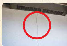
▲老朽化が目立つ嬉野庁舎 (写真右:会議室の至るところでクラック(亀裂)が発生 写真左:コンクリート片の落下が発生)
