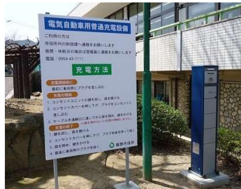
嬉野庁舎前駐車場
