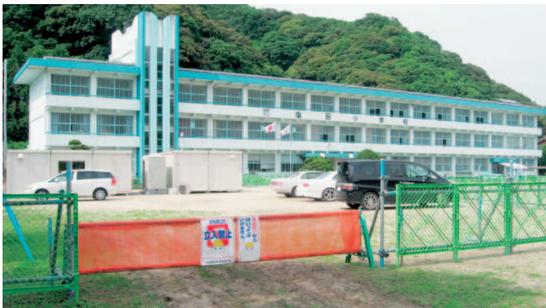
▲耐震工事が行われる予定の塩田小学校
