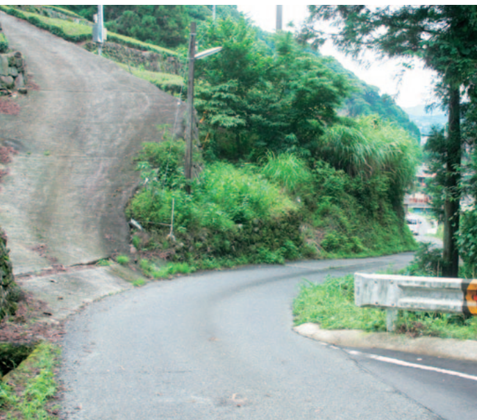
▲改良したい市道小杭線
