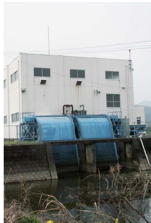
老朽化した排水機場
