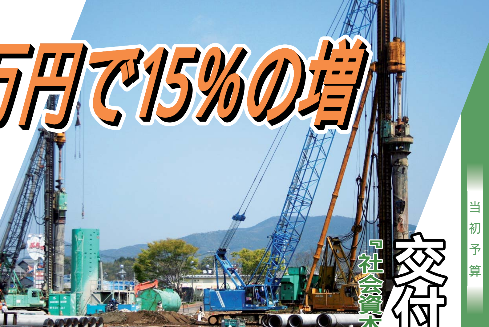
着々と工事が進む塩田中の建設現場
