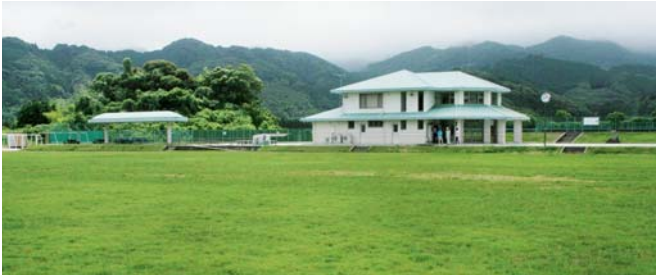
人工芝に改修されるみゆき球技場
