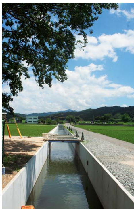
改修工事が行われた花立水路
