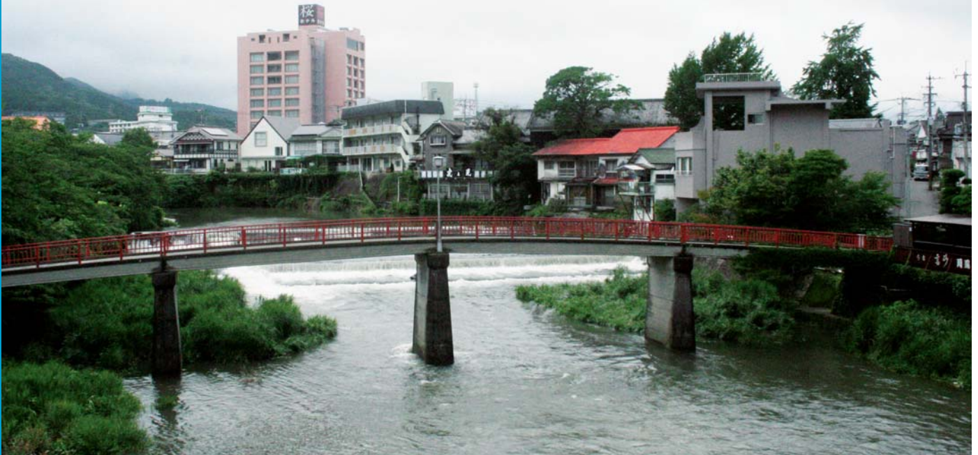
改修される嬉野温泉のシンボルの温泉橋（赤橋）
