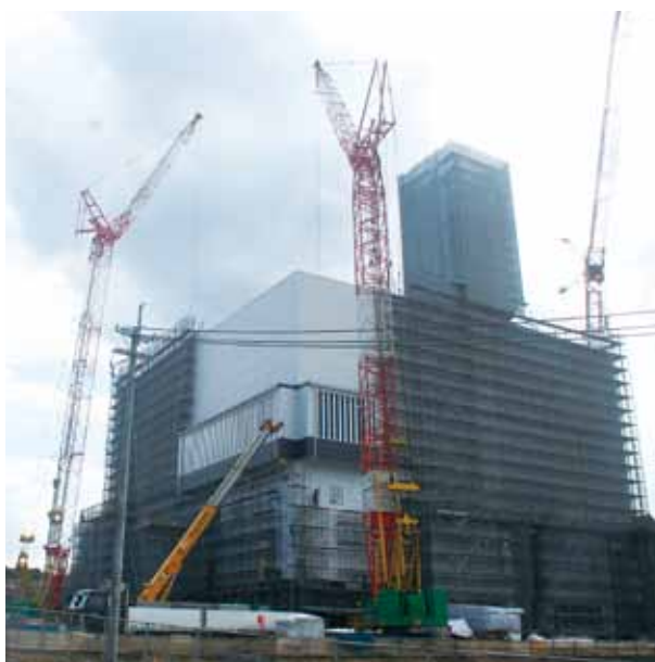
▲完成間近の処理センター（伊万里市）
