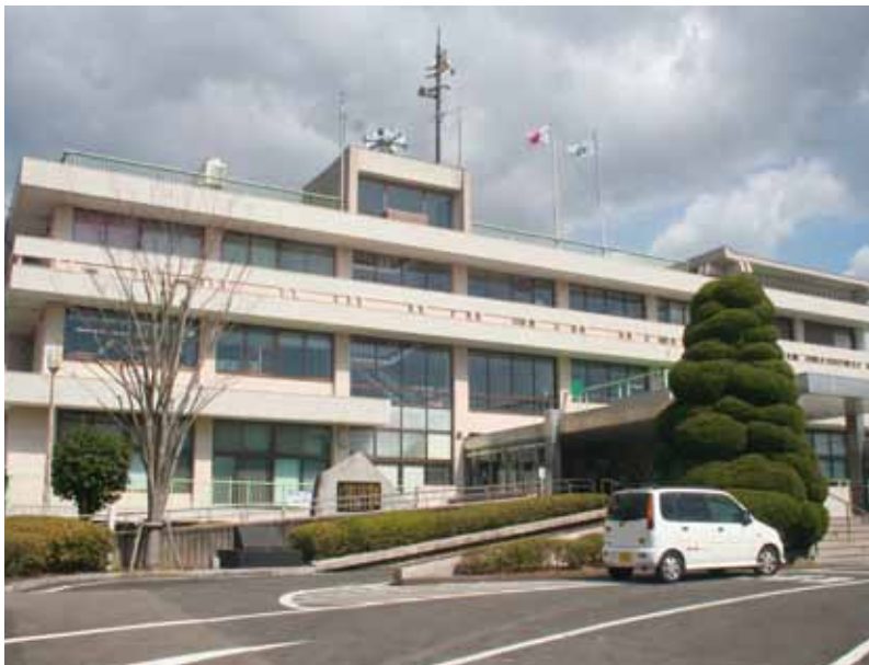
▲老朽化が進む嬉野庁舎
