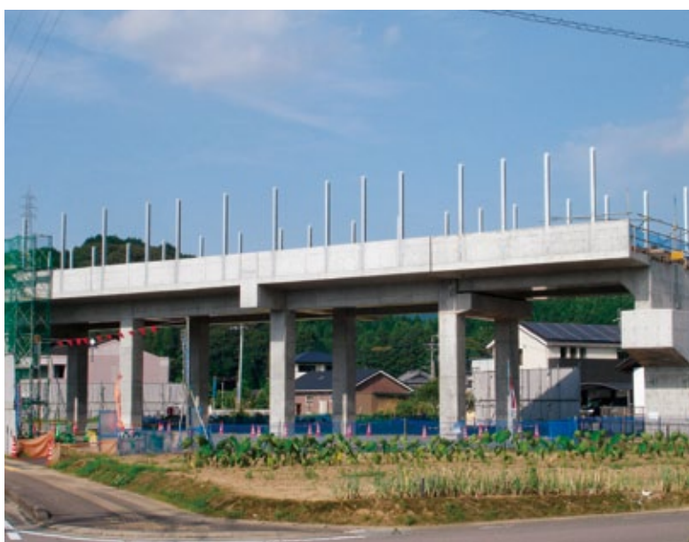
▲透明板での施工を望む防音壁
