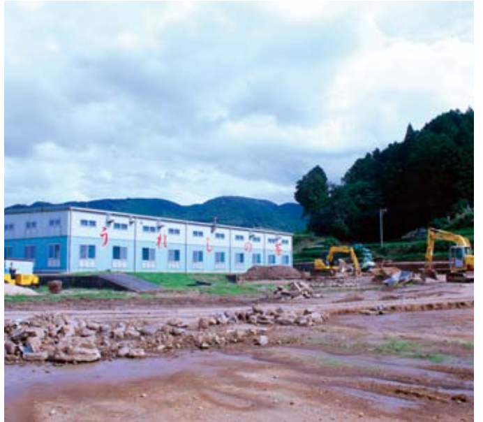
▲造成が進むうれしの茶交流館現場
