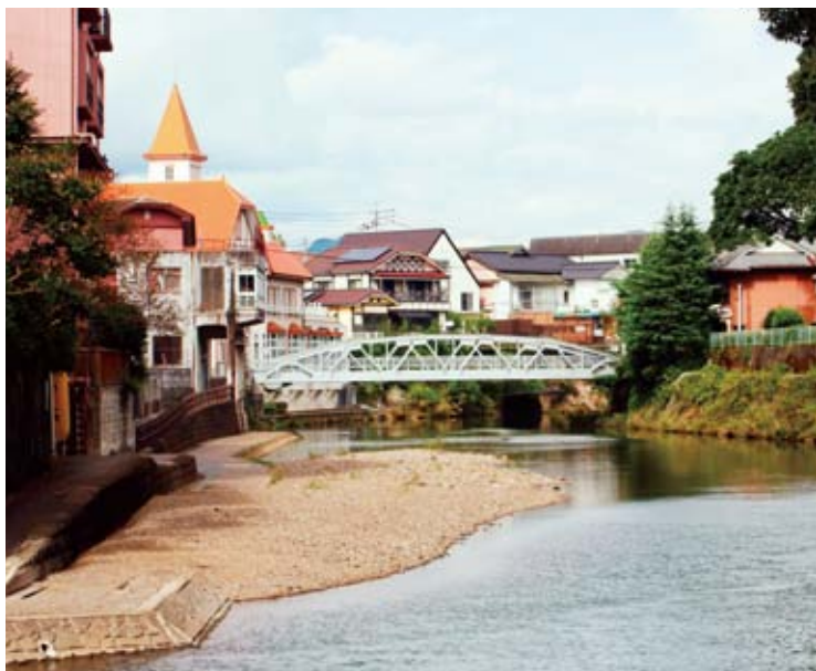
▲土砂が堆積した嬉野川遊歩道
