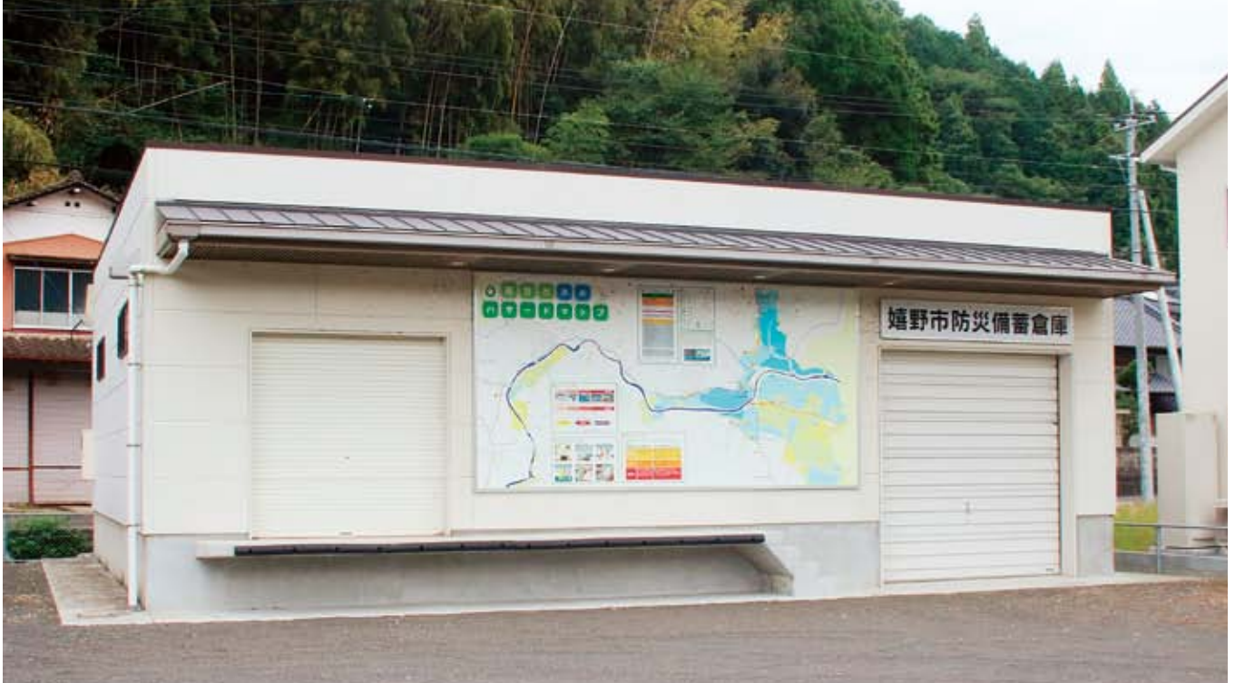
▲災害時に対応する塩田地区防災備蓄倉庫
