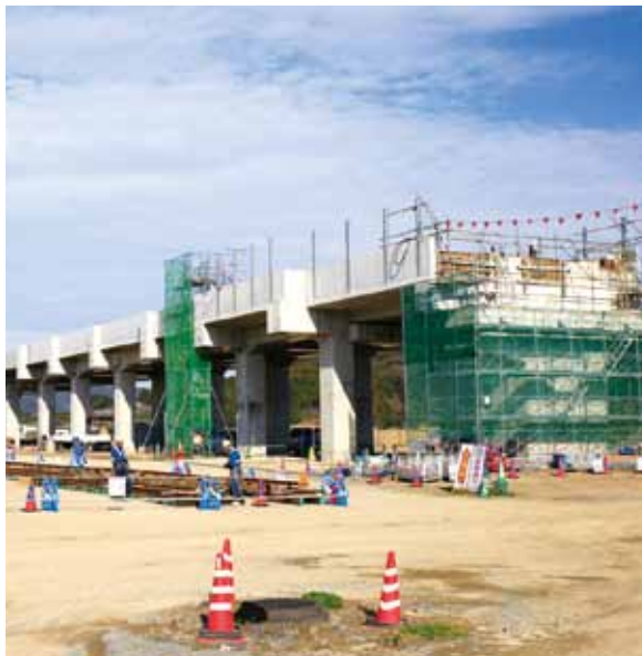
▲着々と工事が進む新幹線駅周辺
