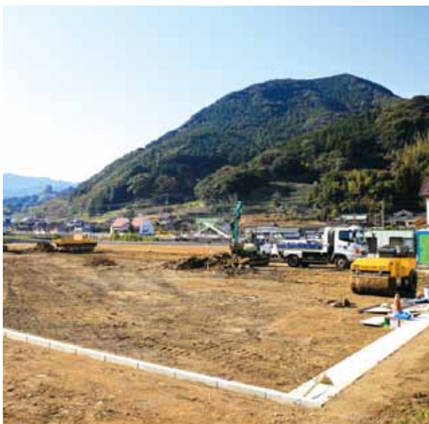
▲造成が進むうれしの茶交流館建設現場
