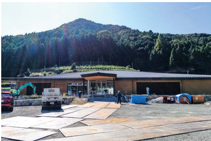
▲来年4月のオープンに向けて建設中のうれしの茶交流館
