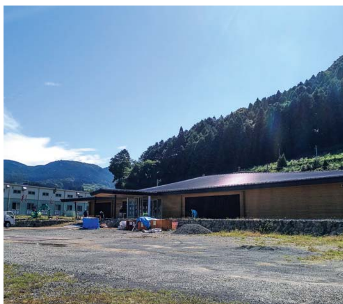
▲着々と工事が進むうれしの茶交流館
