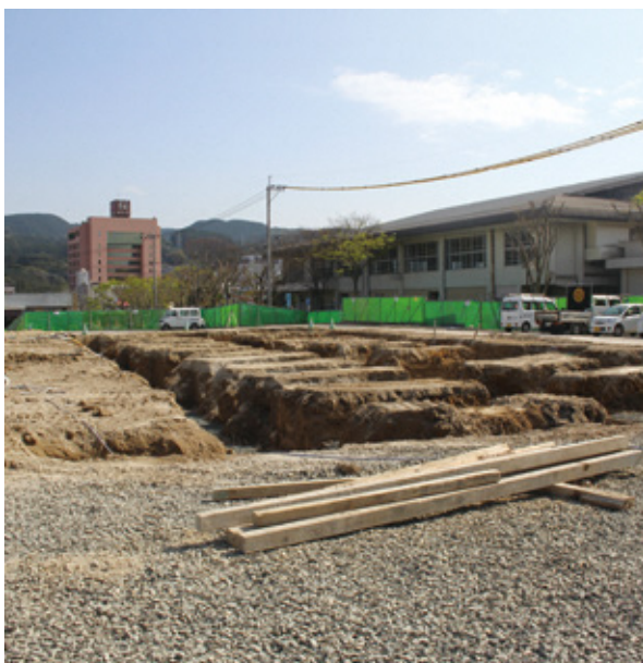
▲建設中の市総合体育館（仮称）
