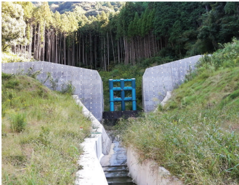
▲土砂災害に有効な砂防ダム
