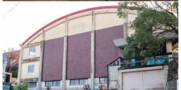
▲解体予定の2つの旧体育館
