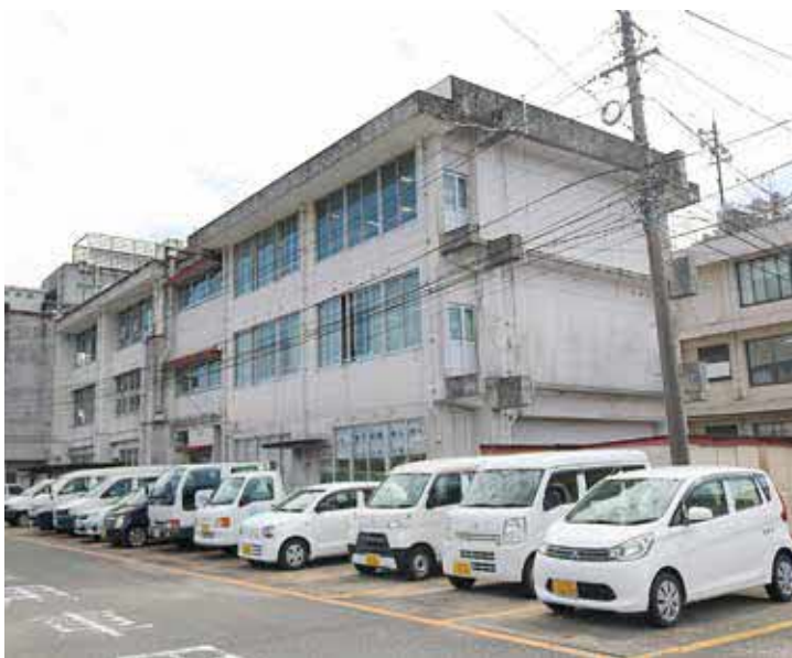
▲ 先に解体される嬉野第2庁舎
