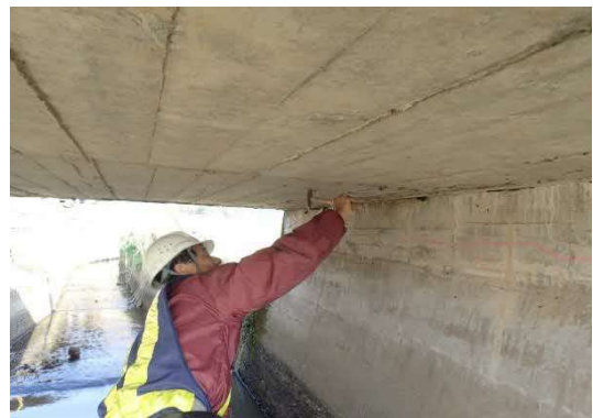
定期点検(打音検査)状況
