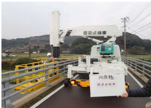
橋梁点検車による定期点検
