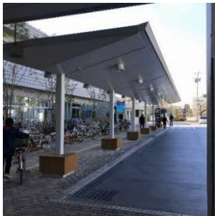
〔車寄せの事例(平塚市庁舎)〕
