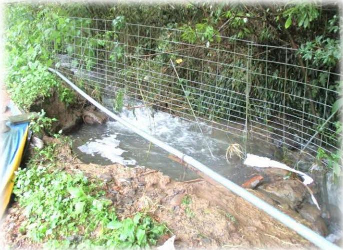
◎**ホテル人工池** …5段になっている人工池の2段目部分の水路側の石積みが、延長5mほど完全に崩壊し、最大1.5mほどが池の方に侵食していました。この崩れた部分には土砂が流入し、その他、全体的には、シートがめくれたりしています。
