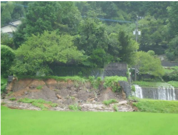
崖崩れによる流入
