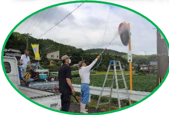
動噴&高圧洗浄機で汚れを洗い流し作業
