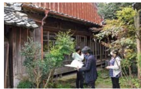
古民家調査(建築物)
