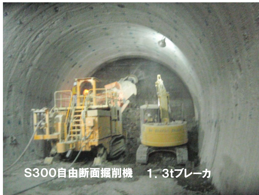
トンネル切羽機械掘削作業状況
