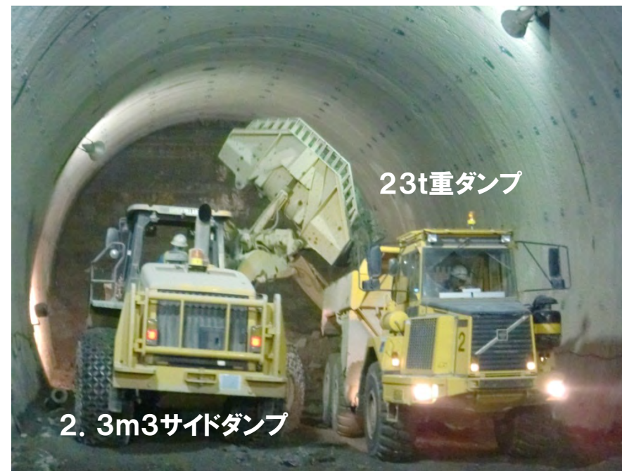
トンネル掘削ずり搬出作業状況（タイヤ方式）
