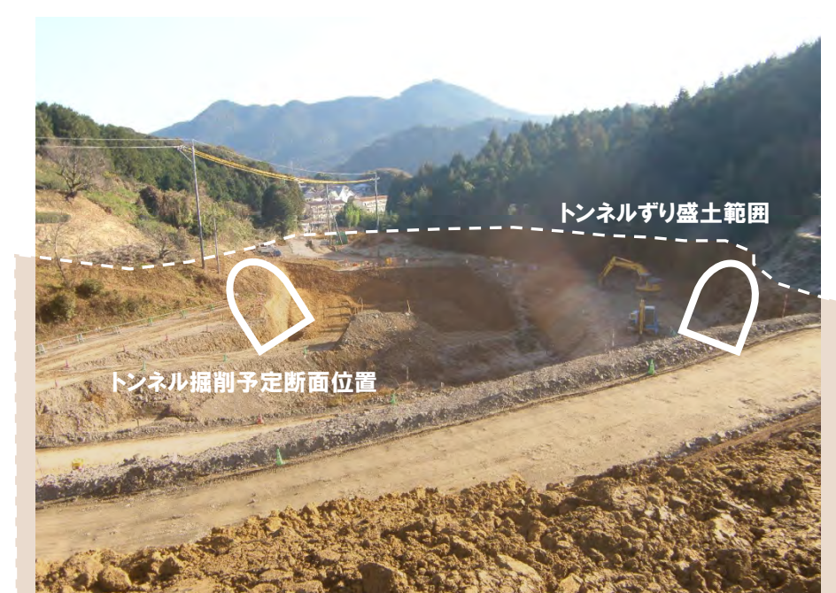
今寺地区 土捨場 改良盛土掘削作業全景
