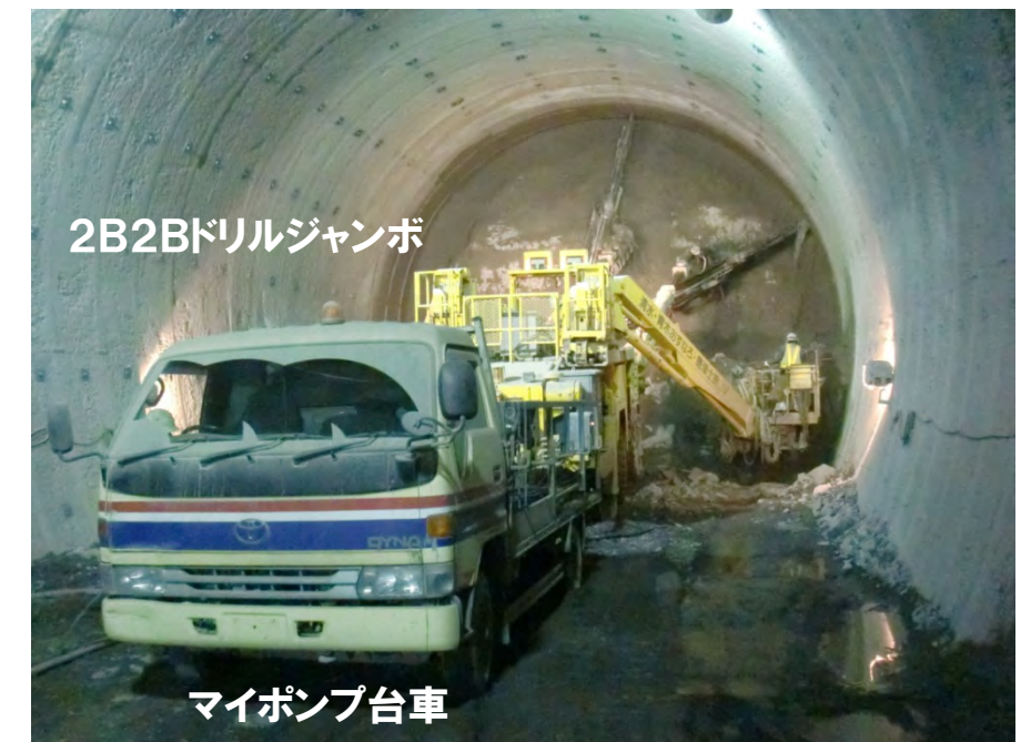
トンネル一次支保（ロックボルト）設置作業状況
