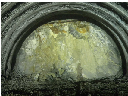
掘削切羽の状況
