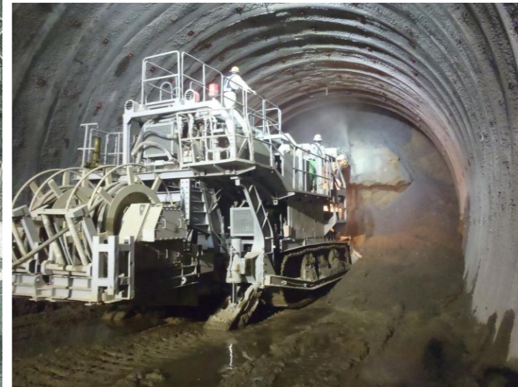
ロードヘッダーによる切削状況(675.8m)
