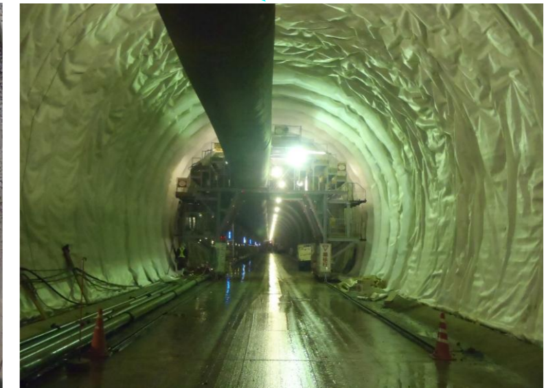
インパットコンクリート・防水シート状況
