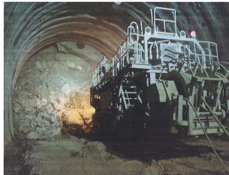
10Jによる切削状況
