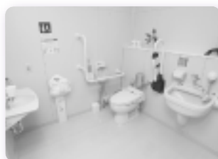
UD対応のトイレ(シーボルトの湯内)
