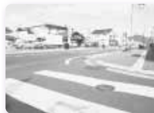
段差のない歩道(国道34号線沿い)
