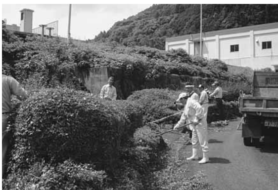
清水浄水場での作業の様子
