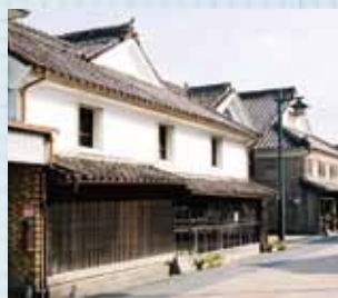
豪商・廻船問屋の屋敷「西岡家住宅」
