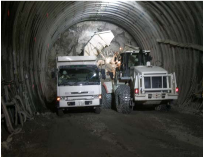
ずり出し状況 (420m附近)
