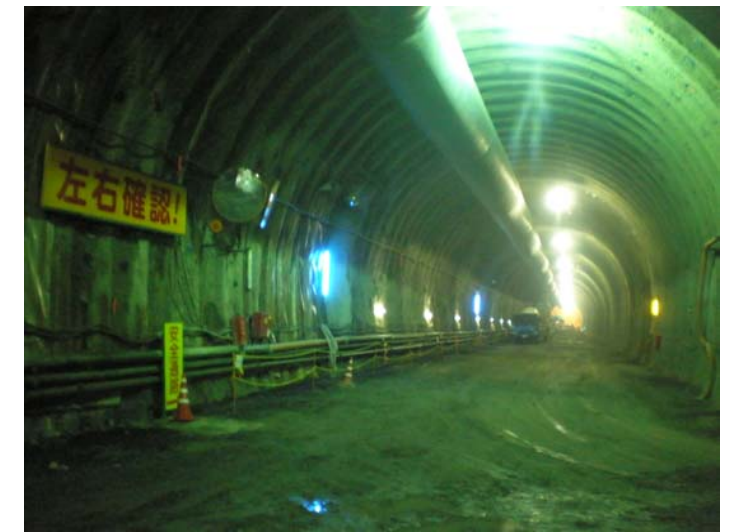
坑内全景(長崎方)
