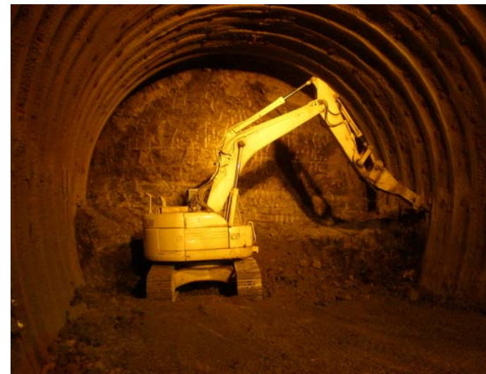
下半掘削状況(14km700m附近)
