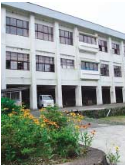
昭和43年2月に完成した大野原小中学校校舎
