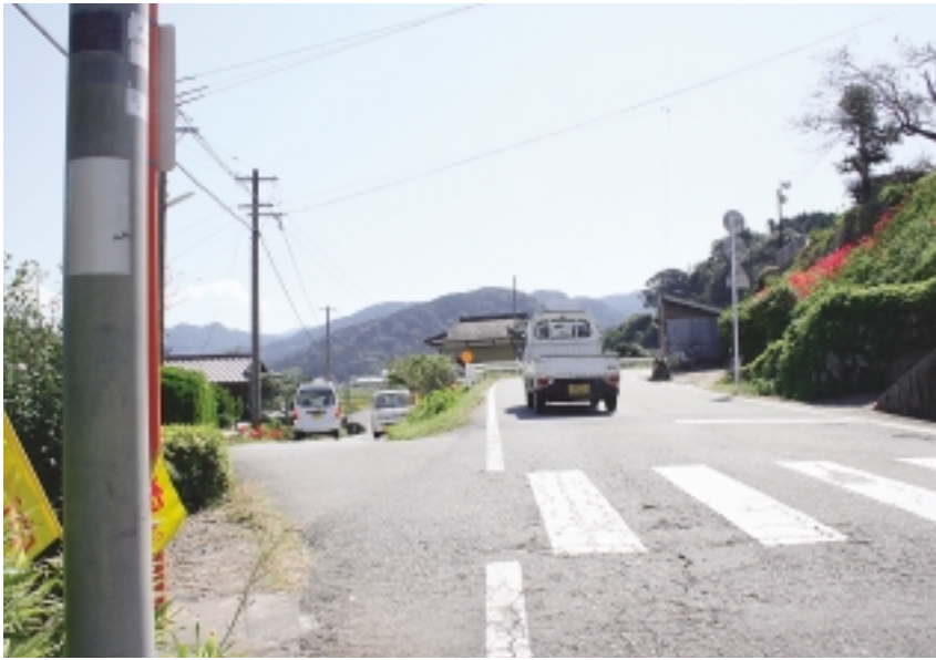
▲動きだした改良工事（納戸料）
