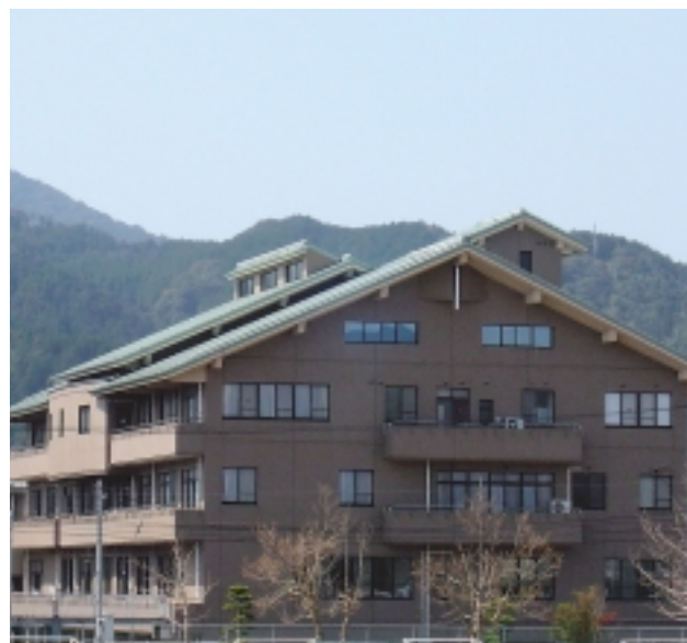
▲多面的な視野での行政の見直しを（後方面から見た本庁舎）
