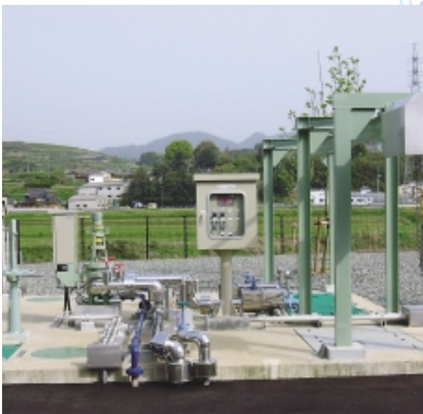
▲きれいな水になり排水（公共下水処理場）
