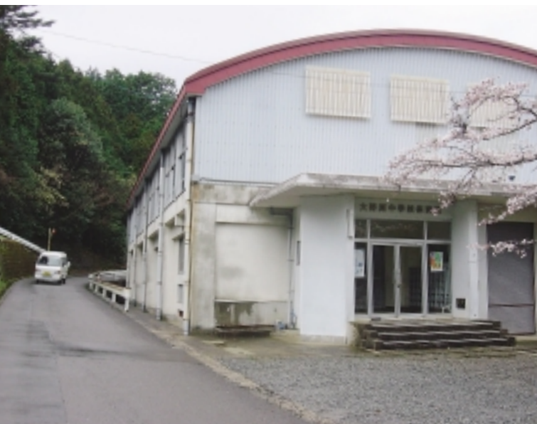
▲今年度解体、19年度新築予定の体育館
