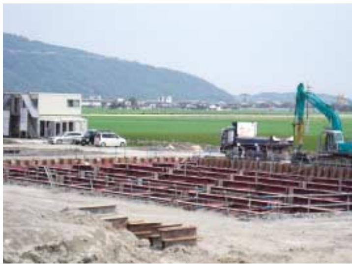
建設が進む五町田、谷所地区の農排処理場
