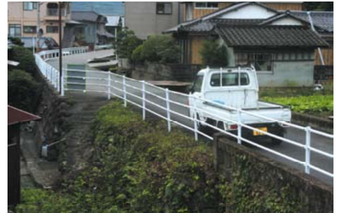
▲改良が望まれる長崎街道のめがね橋
