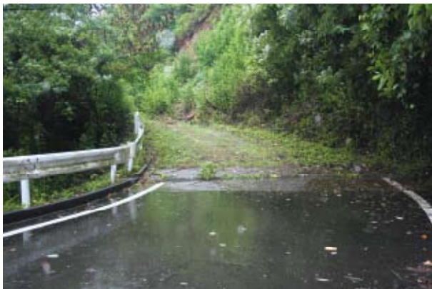
▲舗装される鍋野林道
