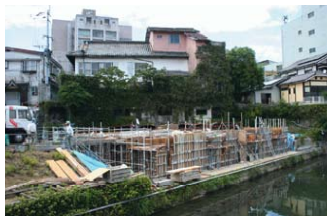
▲工事はできるかぎり地元業者で
