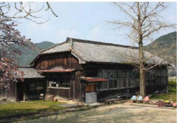
▲修理後の活用が望まれる旧美野分教場
