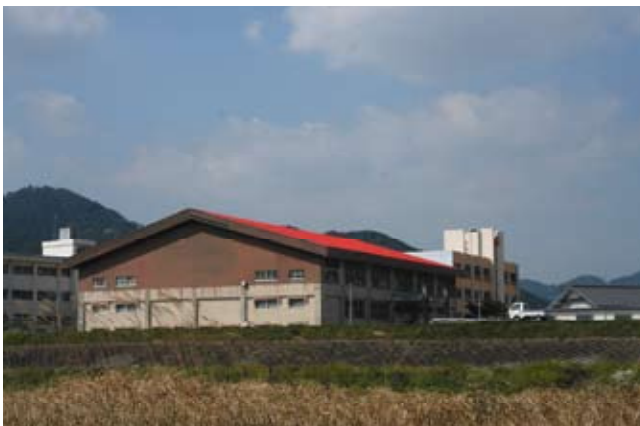
▲袋大橋下河川敷から見た塩田中学校
