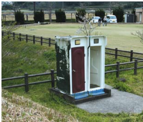
▲現在の仮設トイレ
