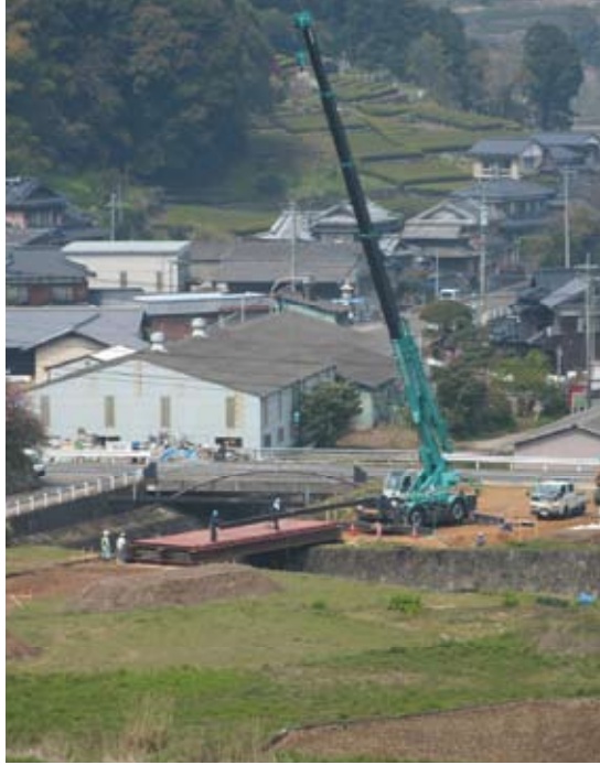
▲始まったトンネル工事前仮設道工事
