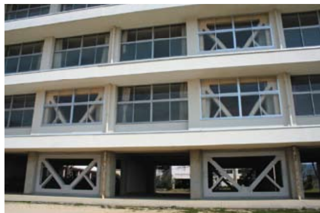
▲補強の済んだ普通教室棟
