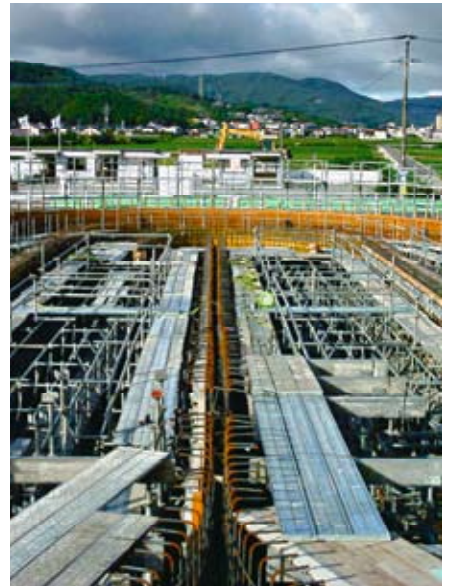
▲1基目の工事（平成16年夏）
