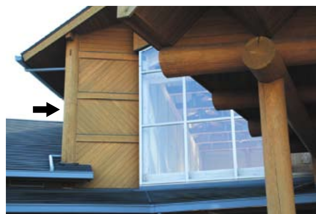
▲風雨にさらされた、むき出しの丸柱
