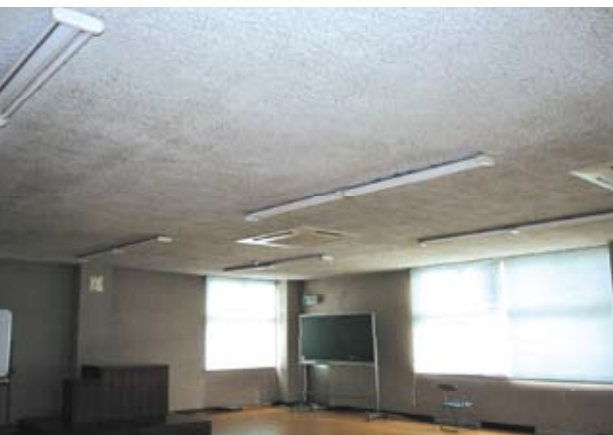
▲使うことができない嬉野町商工会3階会議室
