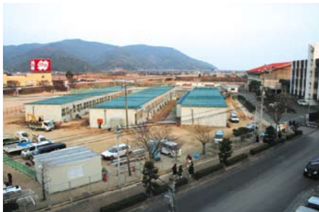
▲完成した仮設校舎(塩田中)
