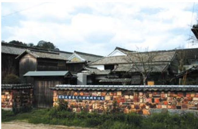
▲保存工事が始まる西岡家
