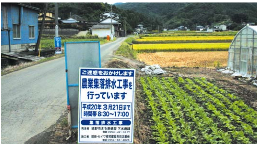
▲工事が進む谷所地区
